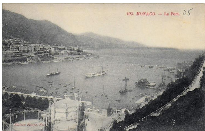
Fig.17- CPA MONACO – Le port (au premier plan les gazomètres de la Condamine) © Coll. RY Dubos
