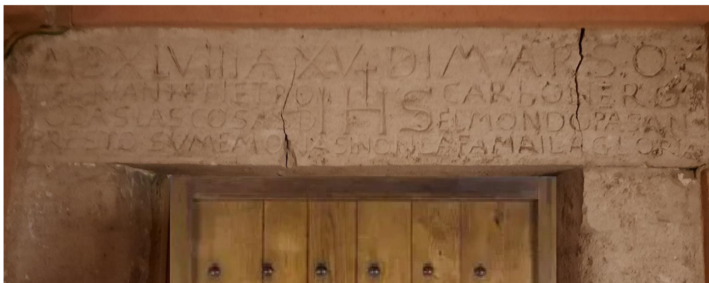
Fig.13 – Cliché du linteau de porte – Passage de la Miséricorde © Archives photographiques CGHPM
