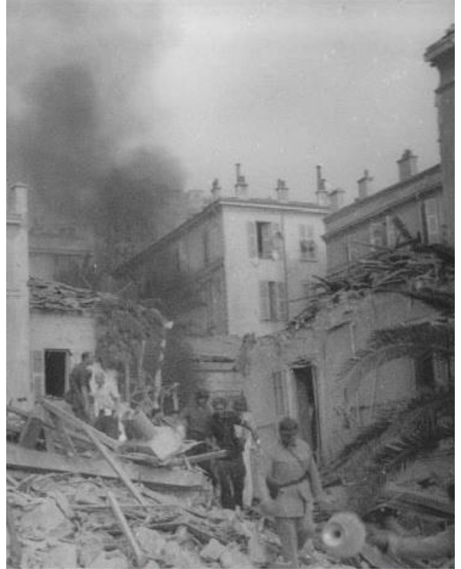
après l'explosion d'une bombe incendiaire
